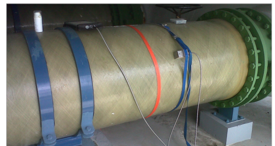
Auf einer großen Glasfaserrohrleitung installierter KATflow 230 mit K0-Sensoren
